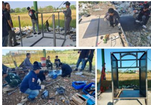
Gambar 3 Proses fabrikasi insinerator
