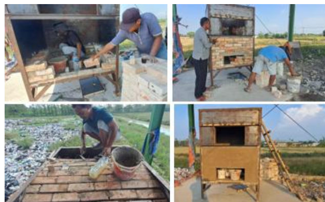
Gambar 4 Pemasangan dinding bata tahan api finishing plesteran
