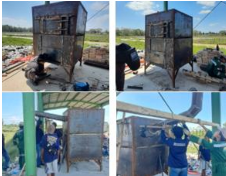
Gambar 5 Fabrikasi pemasang daun pintu
