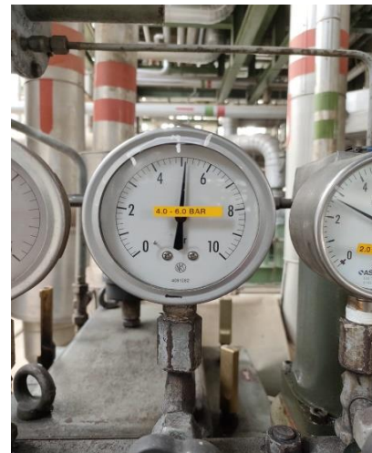
Gambar 9. Indikator Filter Oli
