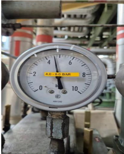
Gambar 10. menunjukkan angka 4,6 bar untuk nilai kebersihan pada filter
