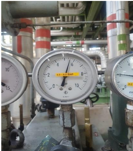
Gambar 6. Indikator Filter Oli
