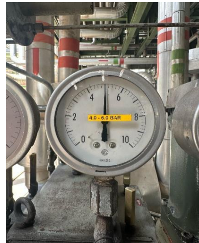
Gambar 8. Indikator Filter Oli
