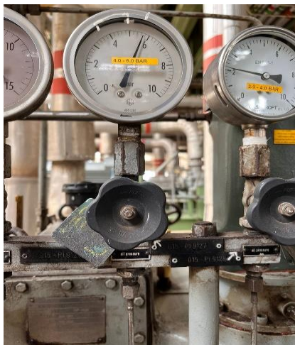
Gambar 7. Indikator Filter Oli
